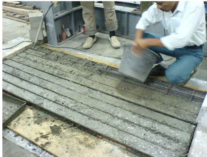
Gambar 8. Pengecoran profil C
