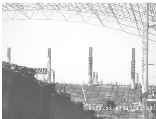
Gambar 6. Kolom dan bekistingnya
